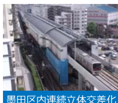
墨田区内連続立体交差化
