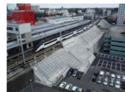
成田駅法面補強
