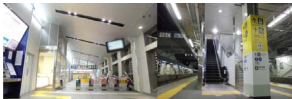
京成津田沼駅駅舎改良工事
